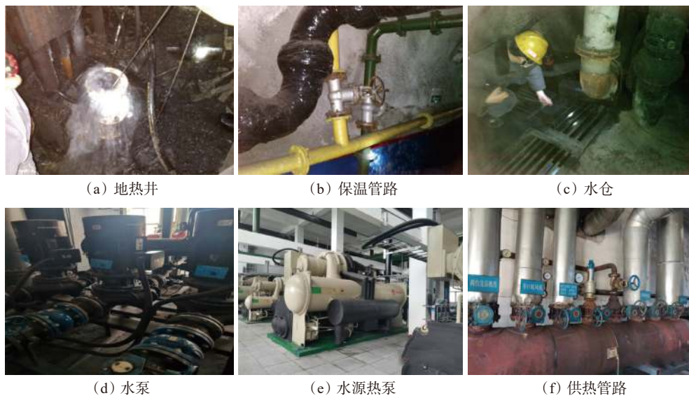
图 6 矿井地热水开采工业性试验布置
