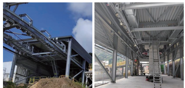
图4 缆车运输压滤尾砂
