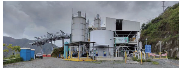
图2 武里蒂卡金矿充填站
