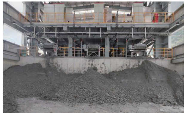
图3 经陶瓷过滤机压滤后的全尾砂
