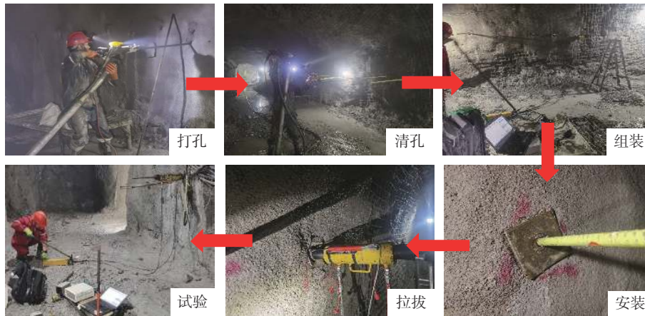
图 7 吸能锚杆现场拉拔试验
